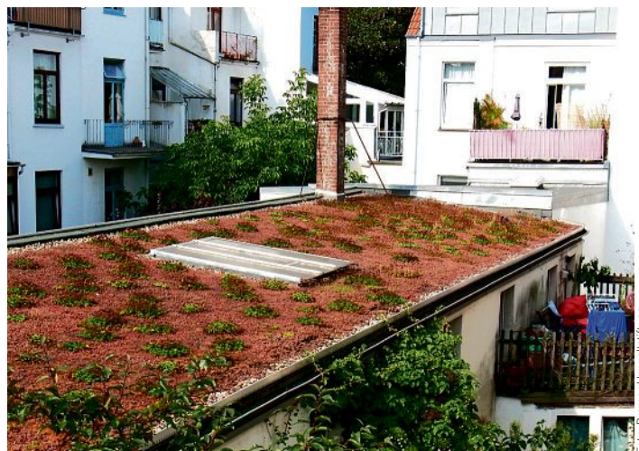
Eine gelungene Dachbegrünung im Bestand.
