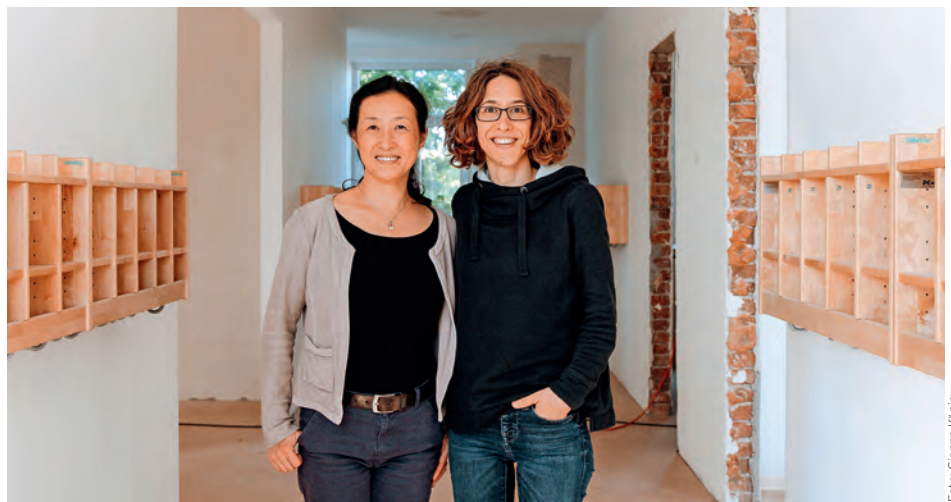
Sie freuen sich auf die Eröffnung ihres neuen KiTa-Standorts am Schiffbauerweg: Yan Guo und Melanie Tang von Drachenkinder e.V. zwischen bereits montierten Garderobenmöbeln.
